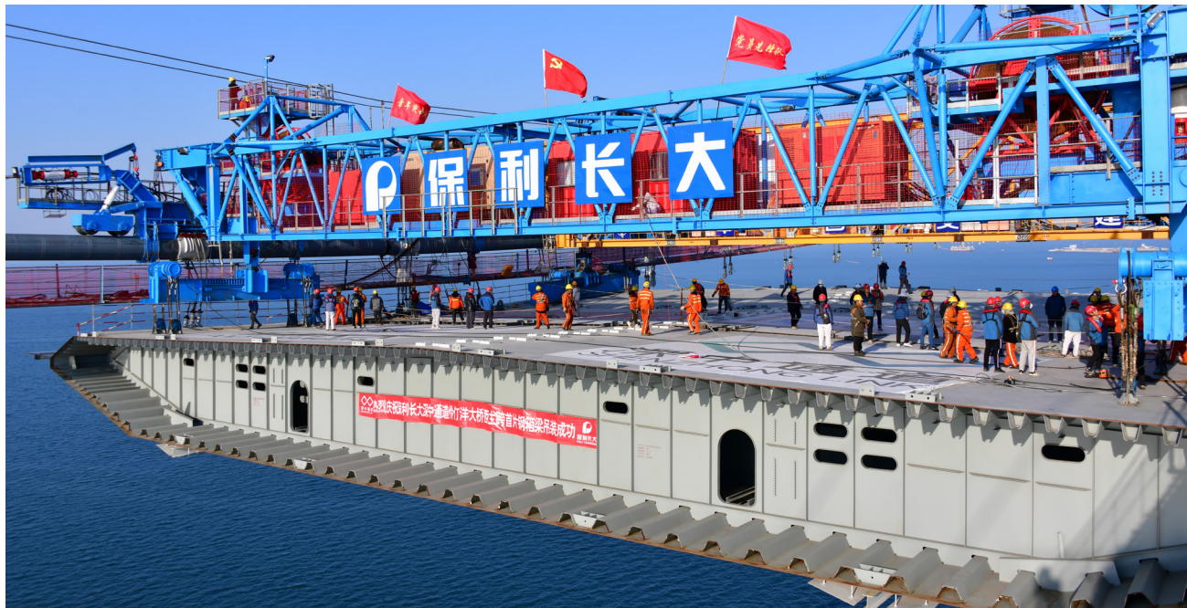
深中通道 S05 标伶仃洋大桥项目伶仃洋大桥主跨西侧首件钢箱梁吊装成功
